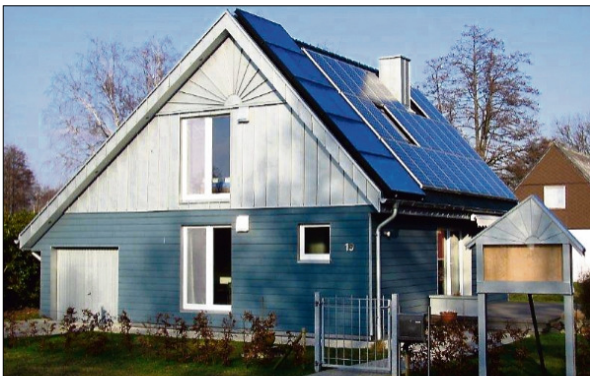
AUCH DIESES Wochenendhaus wurde komplett saniert.
